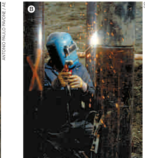
Trabalhador manipulando maçarico oxiacetilênico.
