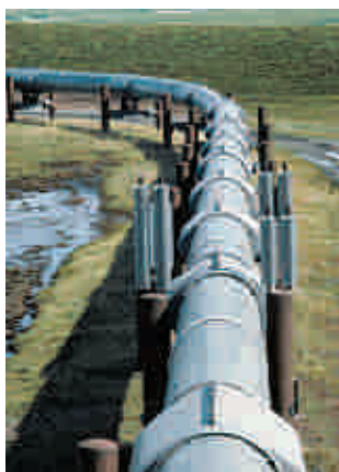
Trecho de um oleoduto.
