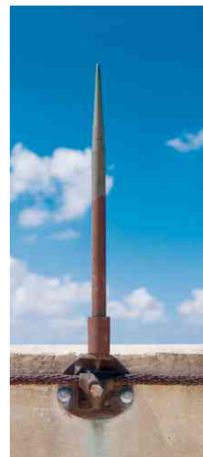
Figura 5.10 O funcionamento de um para-raios, assim como a atração que objetos altos oferecem a raios, são explicados pelo poder das pontas em condutores.
